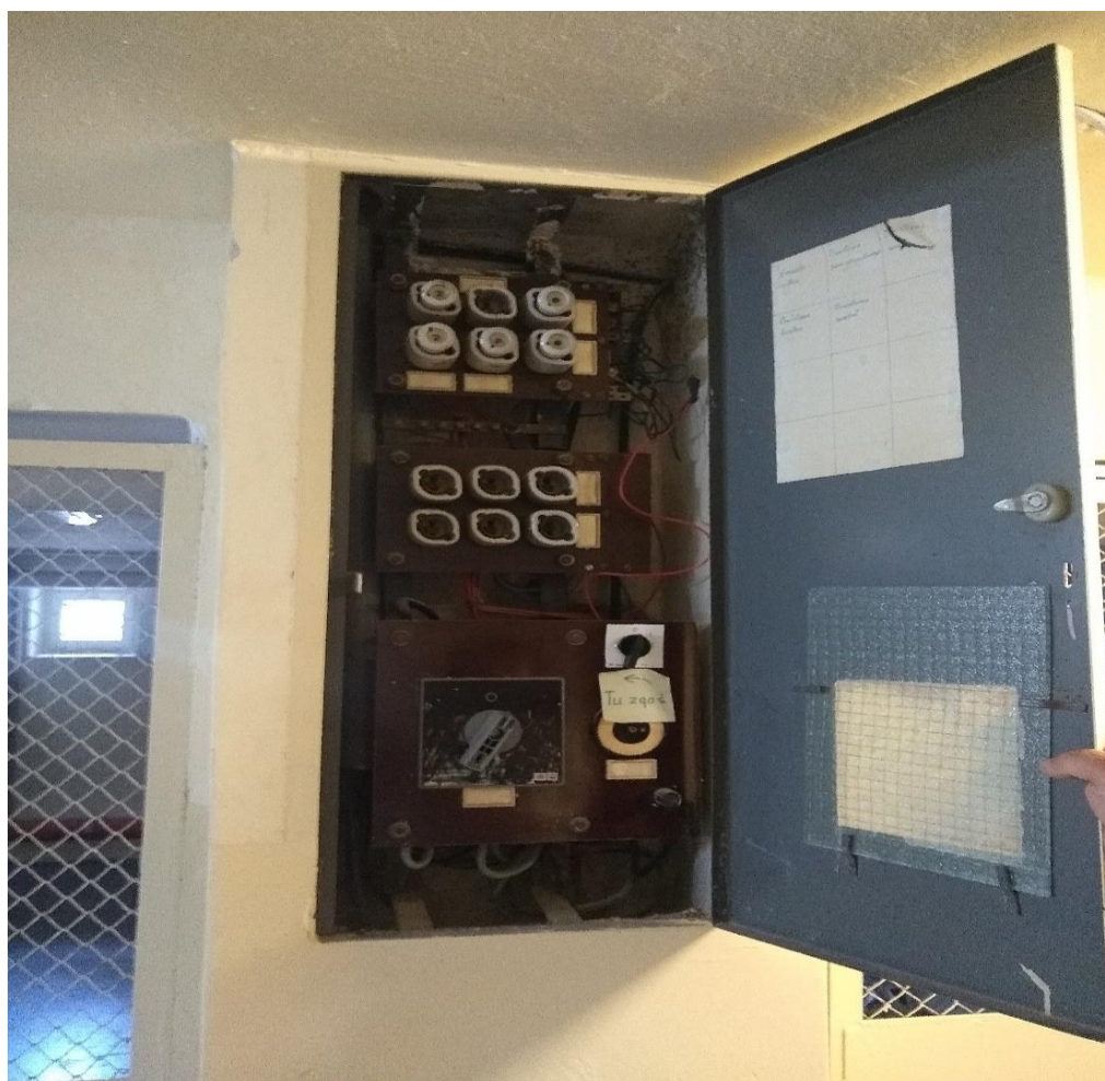
Fot. 12: Widok na płytę czołową rozdzielnic R0
